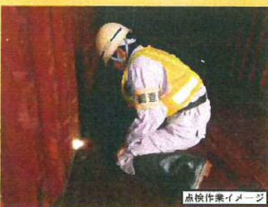
点検作業イメージ
